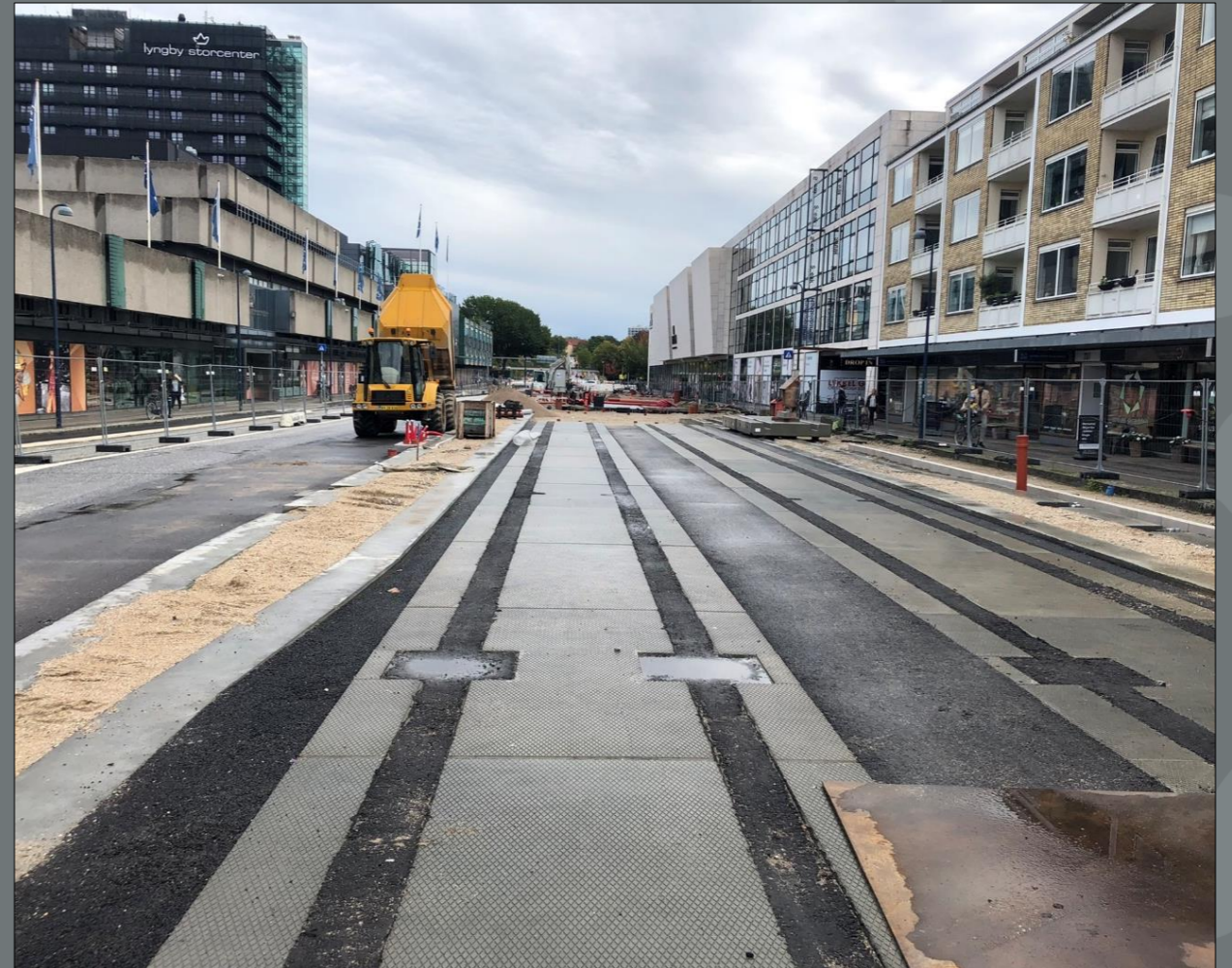
Letbanestrækningen Klampenborgvej – ved Lyngby Storcenter – foråret 2023
