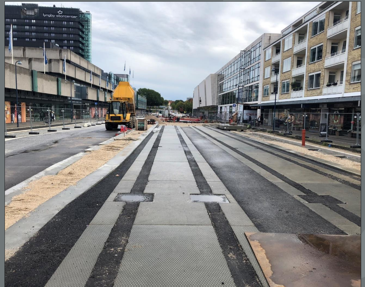
Letbanestrækningen Klampenborgvej – ved Lyngby Storcenter – foråret 2023
