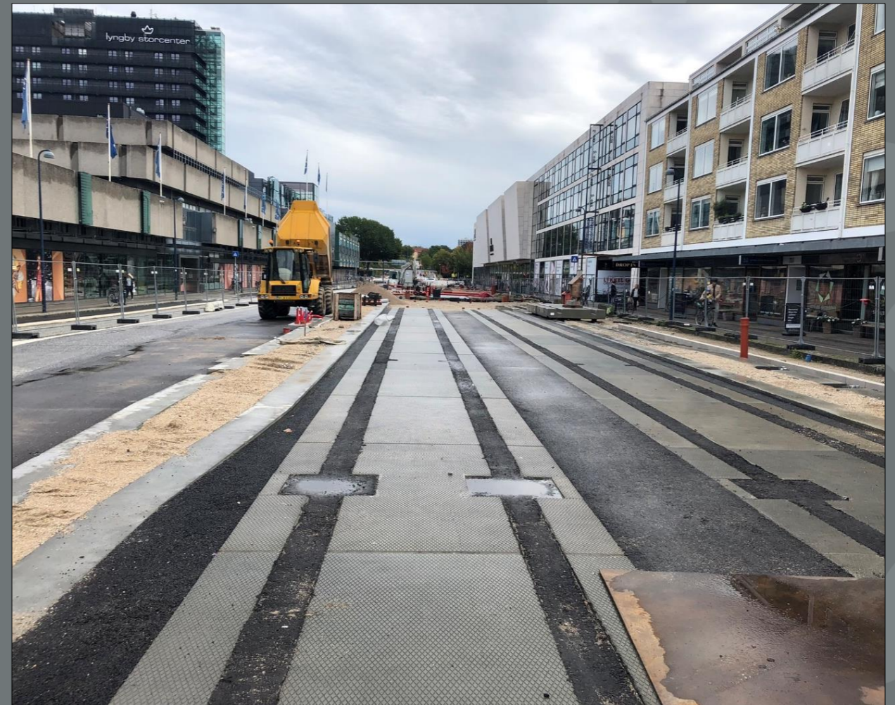
Letbanestrækningen Klampenborgvej – ved Lyngby Storcenter – foråret 2023
